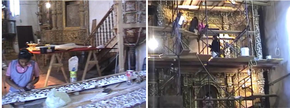
Trabajos de restauración hechos por jóvenes de la comunidad, 2006.
